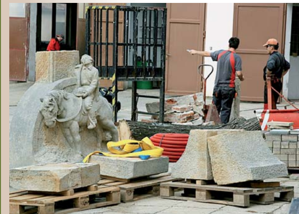
REKONSTRUKCE A OBNOVA NÁPISŮ NA POMNÍKU PADLÝCH
